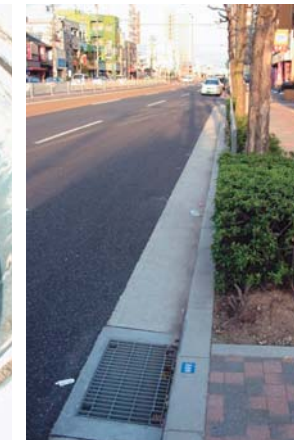
雨水浸透ます(道路)
