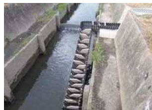
水田魚道の設置
