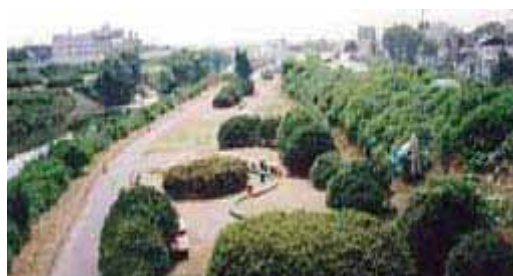
公園として利用されている高水敷 天白川(新島田橋付近)
