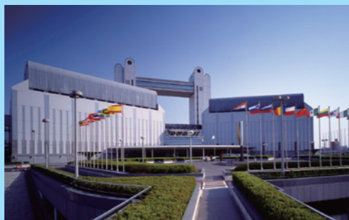
【名古屋国際会議場(名古屋市熱田区)】 3,012席の固定席ホールを有する、中部圏最大の複合コンベンション施設
