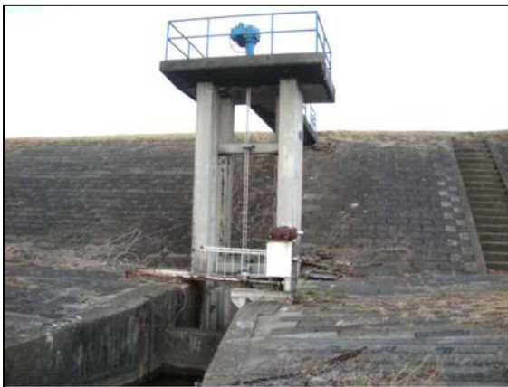
【福原樋門 河川側】
