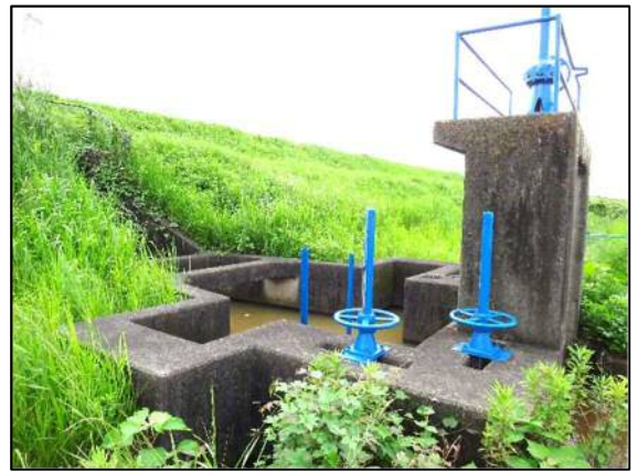
【福原樋門 農地側】
