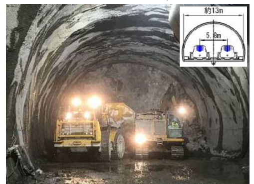
西尾工区トンネル掘削 (本杭 2021.1)
