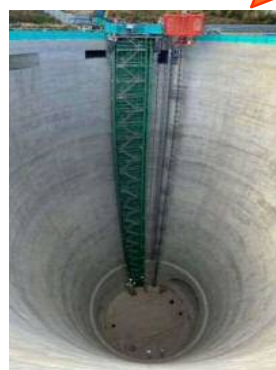
坂下非常口 (2020.10 完成)
