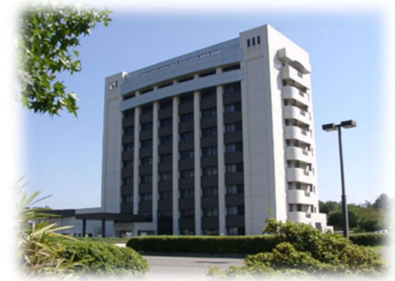
愛知県農業総合試験場 中央研究棟 (長久手市)
