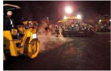
【他空港の大規模補修工事の様子】
