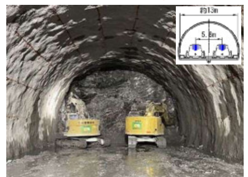
西尾工区トンネル掘削 (本杭 2021.6)
