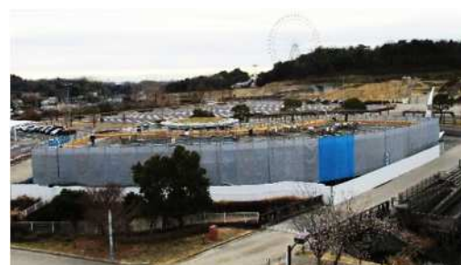
【工事状況(2022.1.25撮影)】 (西口案内所・休憩所)
