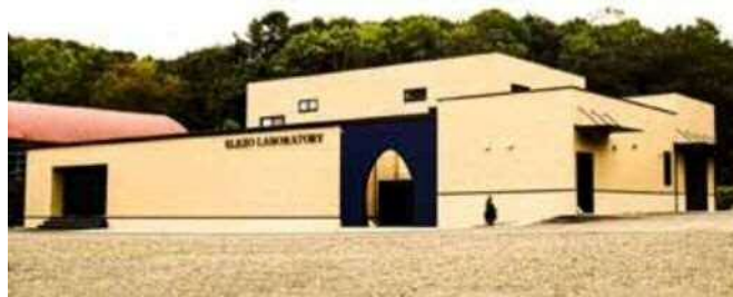
新築のラボラトリー
