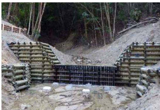
木製校倉式治山ダム工
