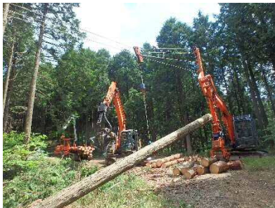
高性能林業機械による伐採木の搬出と造材
