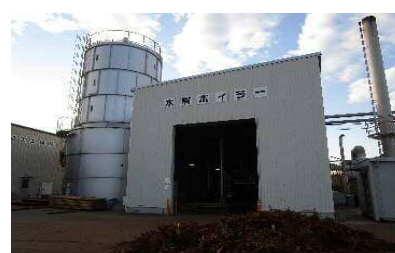
木材乾燥機の熱源となる 木くずボイラー
