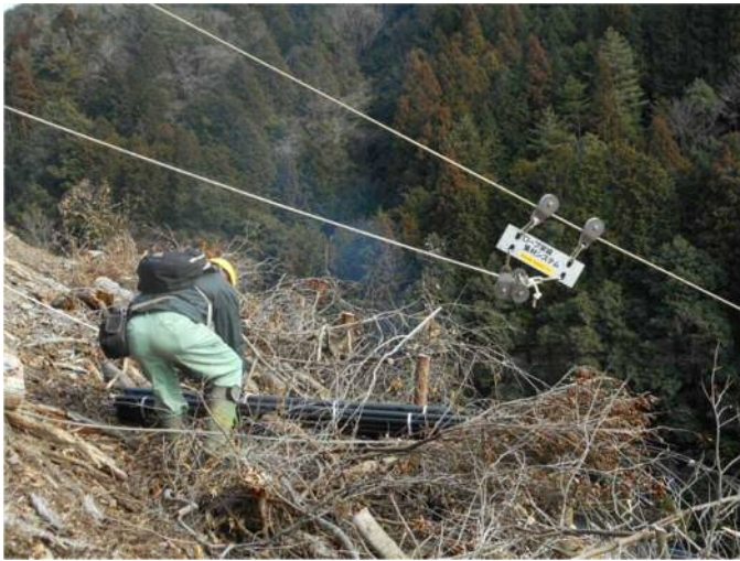
写真 3.8 支柱の荷おろし
