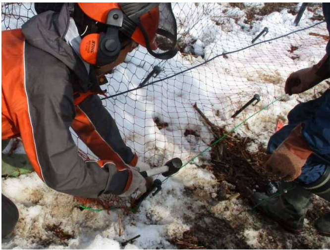
写真 1.8 アンカー杭打ち
