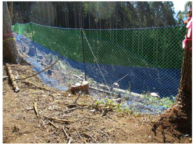
写真 1.9 支柱の補強
