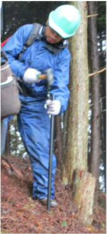
写真 1.3 基礎支柱の打ち込み
