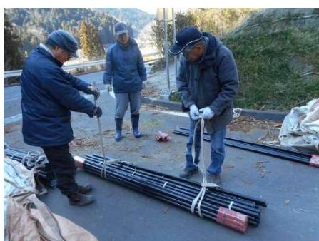
写真 2.2 支柱のロープ縛り
