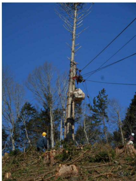
写真 2.6 架線の荷降ろし
