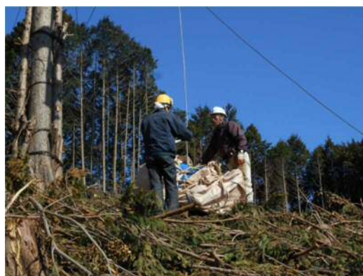
写真 2.7 架線の荷降ろし
