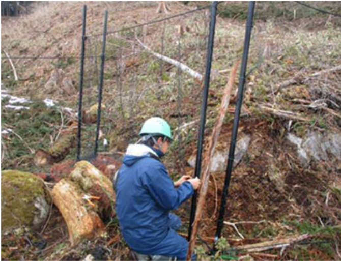
写真 1.10 支柱の増設
