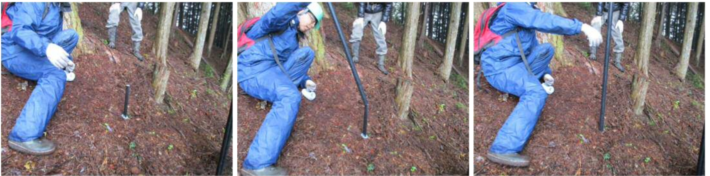
写真 1.4 基礎支柱に上部支柱を被せる
