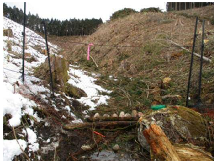
写真 1.13 沢またぎ対応による支柱増設と丸太敷き
