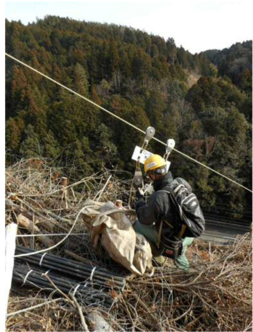
写真 3.9 フレコンパックの荷おろし
