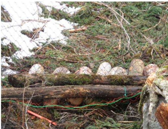
写真 1.12 押さえ丸太と針金固定
