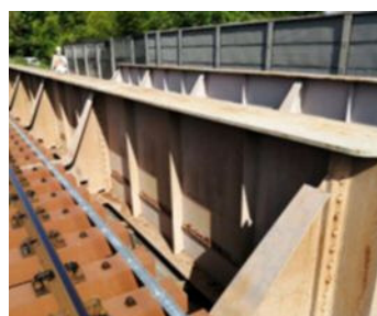
橋りょう修繕
