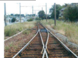
【渥美線】レール・分岐器更新（軌条化）
