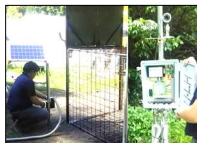
ICT を活用した新しい捕獲設備の設置
