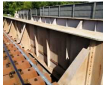
橋りょう塗装
