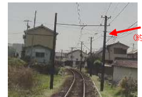
【渥美線】木製電柱のコンクリート化
