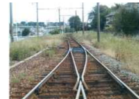
【渥美線】レール・分岐器更新（軌条化）
