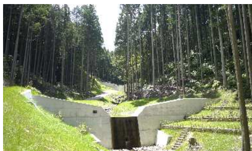
水源地域を守る治山施設
