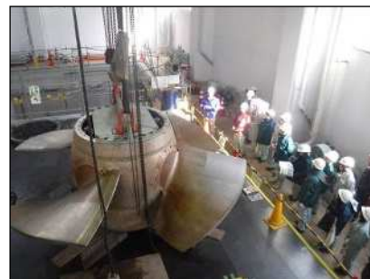
尾張西部 (日光川河口排水機場)
