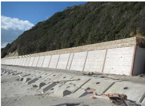
【海岸防災林造成事業（田原市：令和元年度完了）】
