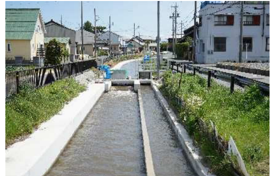
【牟呂幹線水路 下流から望む】
