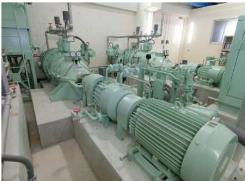
【老津排水機場（豊橋市：令和元年度完了）】
