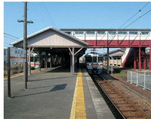
半田駅ホーム(高架工事着手前)
