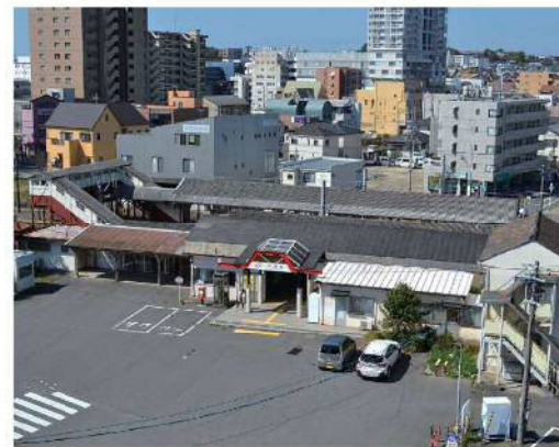
半田駅(高架工事着手前)
