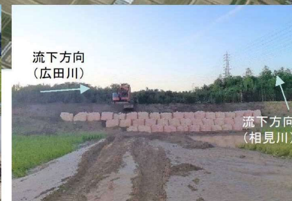
写真② 応急対策完了 9/25 18:00
