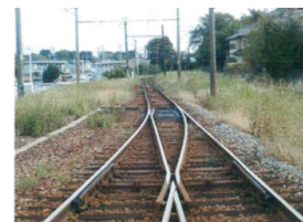
〔渥美線〕レール・分岐器更新（電化対応）
