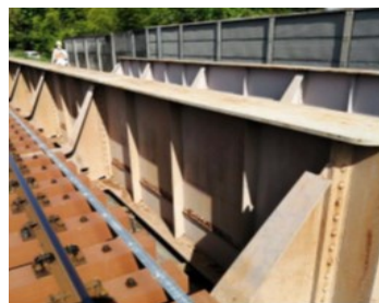
橋りょう塗装
