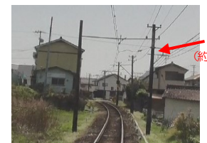
〔渥美線〕木製電柱のコンクリート化 (約60年経過)
