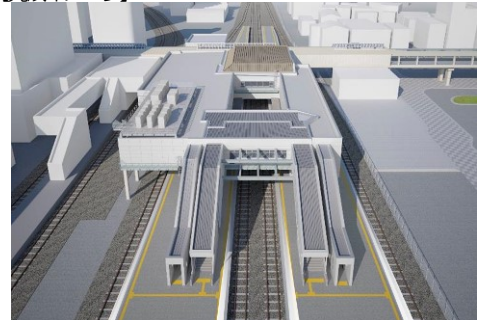
事業内容 ホーム拡張、ホームドア設置、エスカレーター増設、コンコース拡張、改札増設 等
