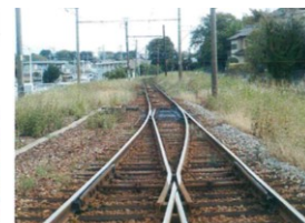
【渥美線】レール・分岐器更新（軌条化）
