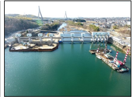
明治用水頭首工地区 土地改良施設突発事故復旧事業
