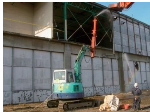
湿潤化の例(散水)
