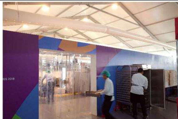
客席と厨房を間仕切り壁・カーテンで区切った例
