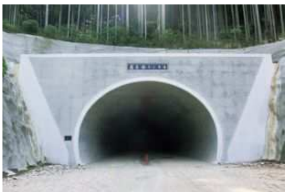
国道473号設楽バイパス 岩古谷トンネル西側(設楽町和市)坑口付近(2014年5月)
