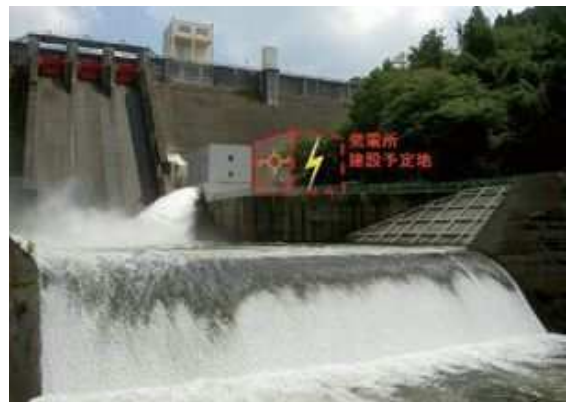
4 羽布ダムを利用した小水力発電の導入
