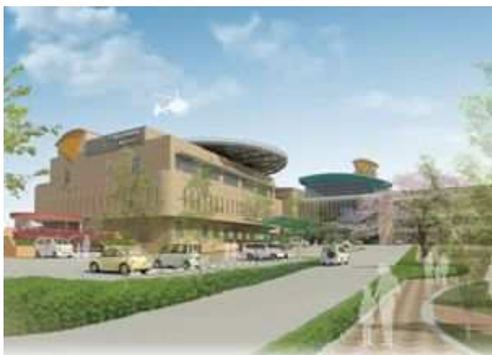
⑤ あいち小児保健医療総合センターの小児3次救急施設整備（イメージパース）
