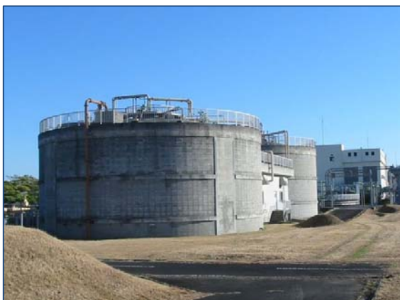
図 5-7 メタン発酵施設 (豊川浄化センター)
