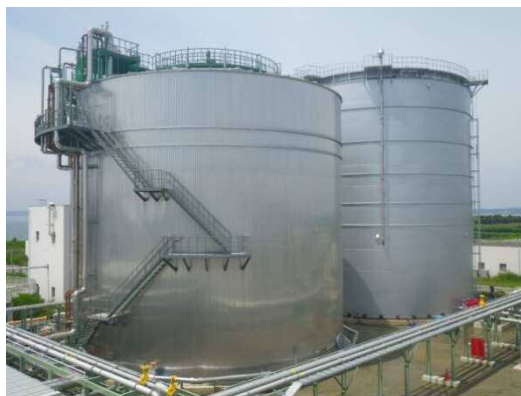
矢作川浄化センターの消化槽
