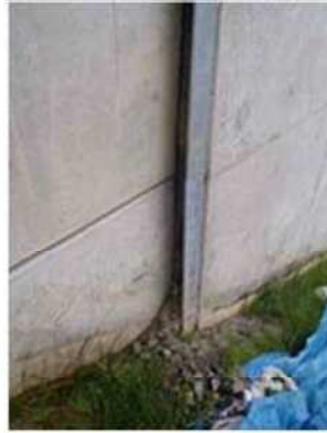
写真 土砂のこぼれ出し例
