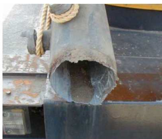
写真-2. 1 路面境界部の腐食が要因となった倒壊事例
