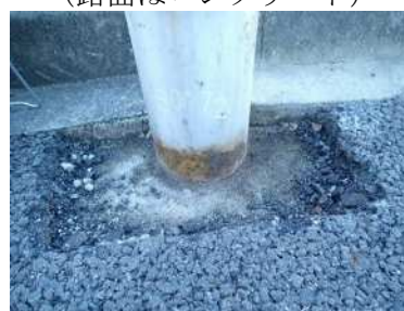
新設後 45 年以上 (塗装式、アスファルト)
