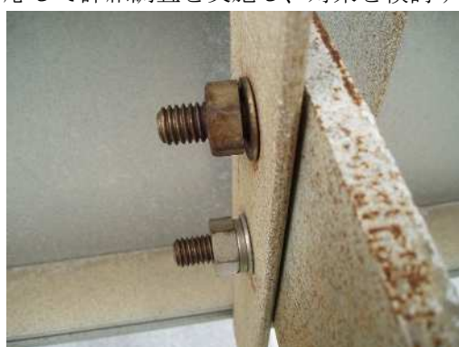
写真-解 8-10 新設後 10 年以内の附属物の変状事例
