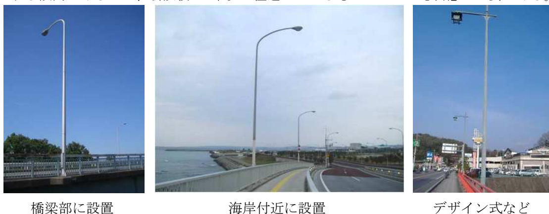
写真-解 8-3 詳細点検を優先する既設附属物の例
