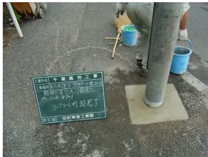
写真・解 12-1 水切りモルタルの施工事例
