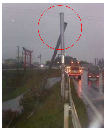
写真-解 8-8 支柱継手部の折損状況
