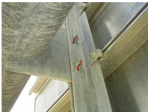
標識板取付部
