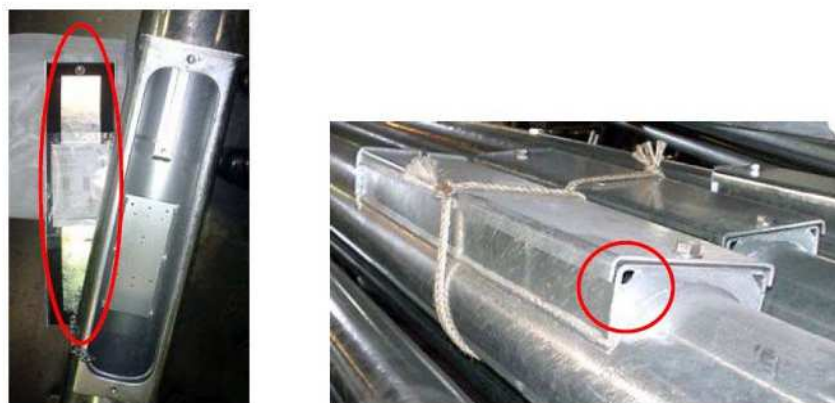
写真-2. 2 電気設備用開口部のパッキンと水抜き穴
