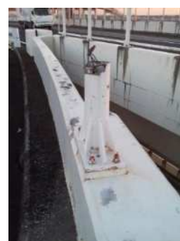
点検用開口部の破断による落下 (高架橋、21年経過)
