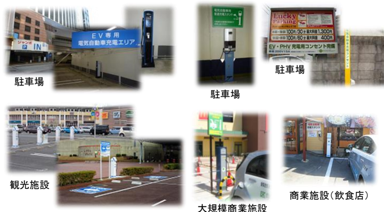
図4-8 県内の充電インフラ整備例
