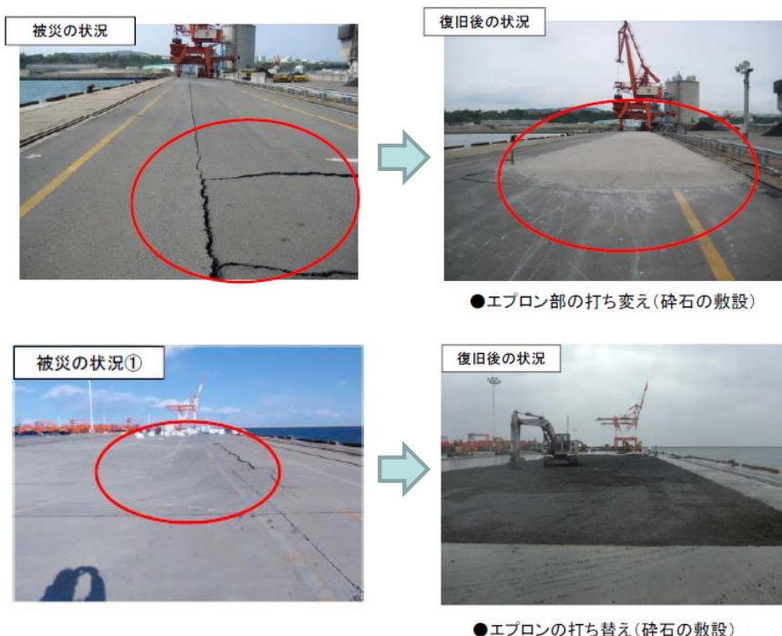
図-4 岸壁・エプロンの応急復旧工事フロー図
