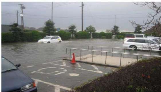
(a) 三河港務所浸水状況
