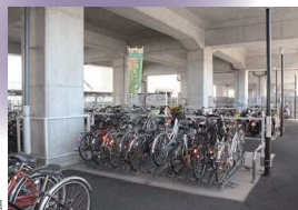
高架下を利用した駐輪場
