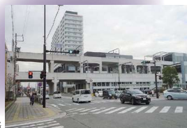
踏切が除却された道路
