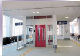
駅に設置されたエレベーター
