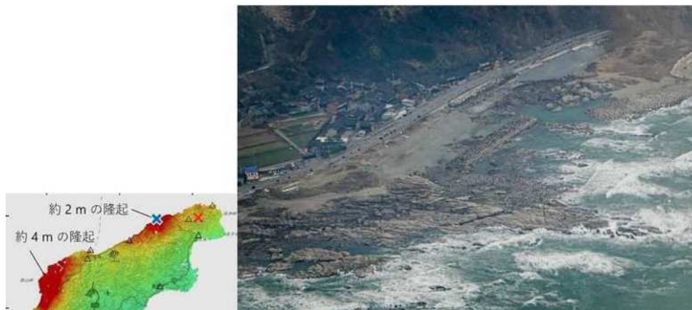
図 6d：珠洲市北部の海岸。消波ブロックの場所も含めて広い範囲が陸化している。
