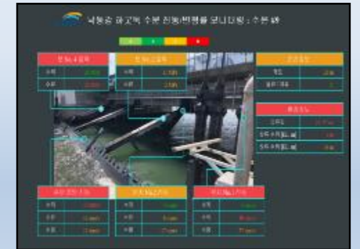
<振動/変形監視システム>
