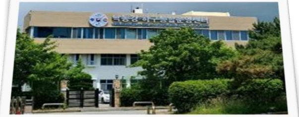
< 洛東江河口統合運営センター開所('21.3)>
