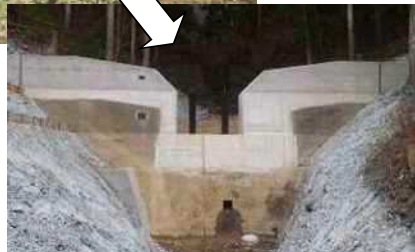
谷止工嵩上げと流木捕捉機能(鋼製スリット)の付加
