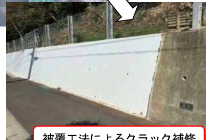
被覆工法によるクラック補修
