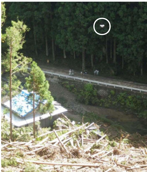
被災箇所の調査
