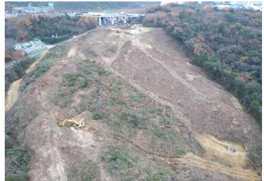
新種鶏場 用地造成工事（2018年12月）
