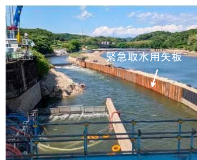
緊急取水用矢板の設置状況 (頭首工から上流を臨む)
