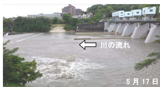
頭首工下流の様子(激しく噴き出している)
