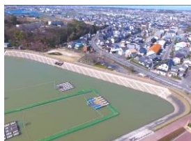
ため池の耐震対策
