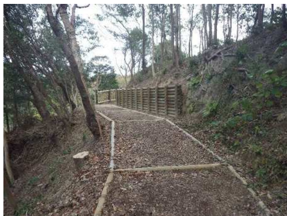
木質チップを敷き詰めた作業歩道
