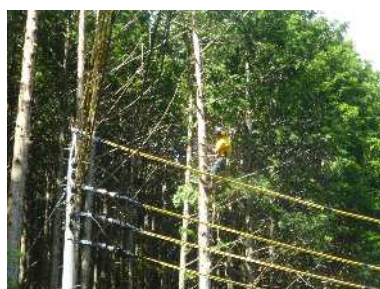
樹上での作業(設楽町)
