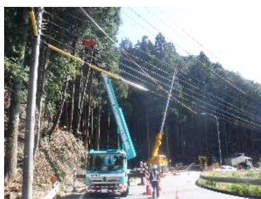
重機を使用した伐採(新城市)
