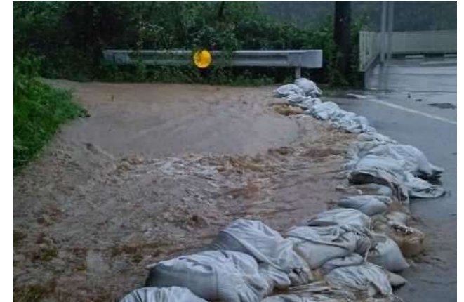
浸水防止のため積み土のう工を実施 (豊川市御油町)
