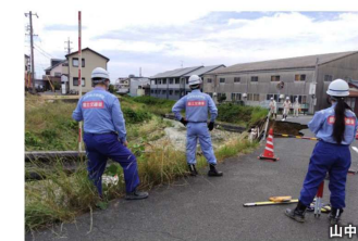
復旧資材の提供
