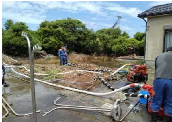
排水作業 (田原市西山町)
