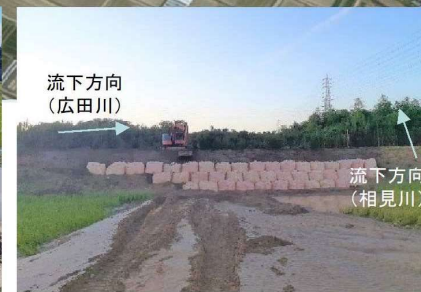
写真② 応急対策完了 9/25 18:00
