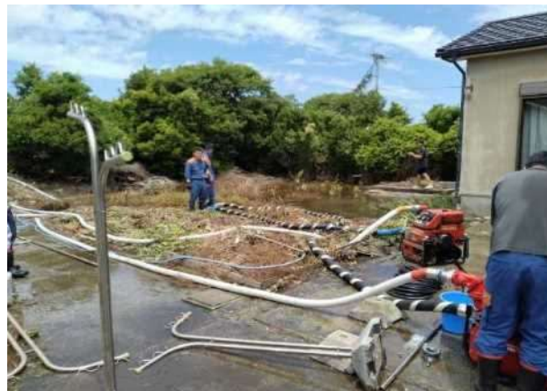
排水作業 (田原市西山町)
