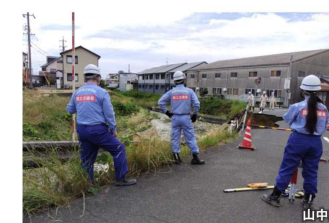
復旧資材の提供
