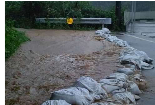
浸水防止のため積み土のう工を実施 (豊川市御油町)
