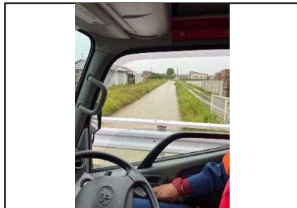
①発杭川（東境町） 河川巡視
