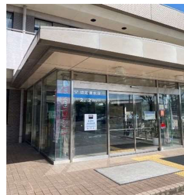
整備施設(公民館)
