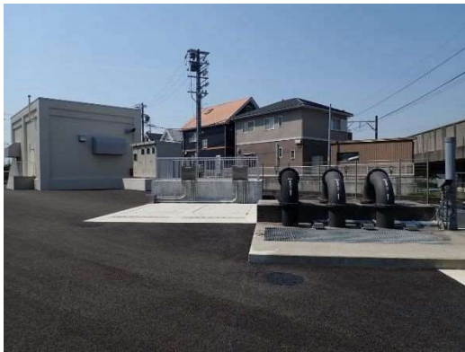
宮前ポンプ場の整備
