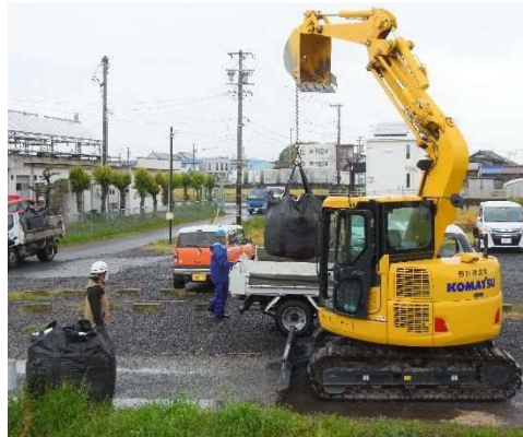
大型土のう設置訓練
