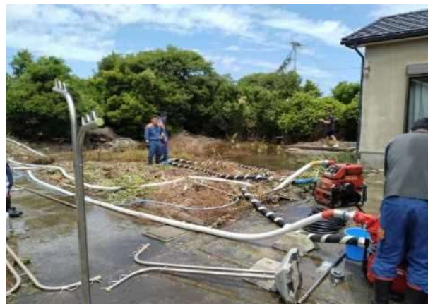
排水作業 (田原市西山町)
