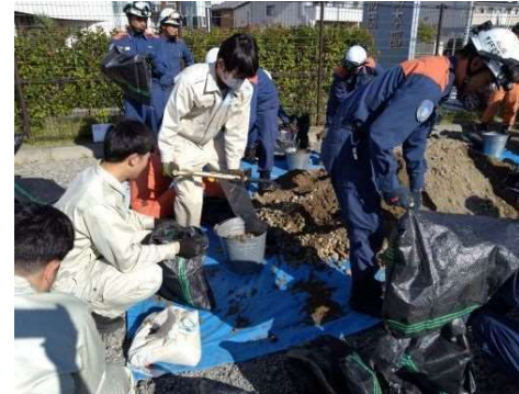
土のう作成の様子
