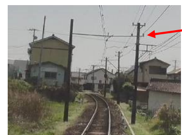
【渥美線】木製電柱のコンクリート化
