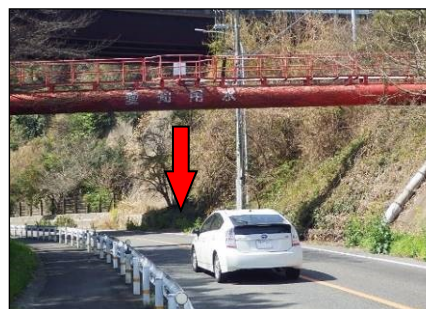
愛知用水<師崎支線> (地震時に落下が危惧される水管橋)
