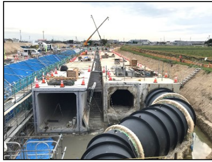
矢作川総合第二期 (明治用水幹線水路)
