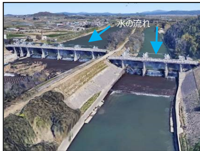
矢作川沿岸 (吉良・古川頭首工)
