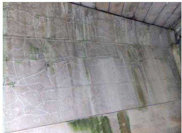
写真 6-14 下部工 縦壁のひびわれ（ASR）
