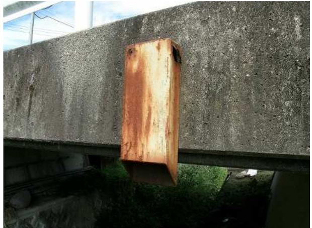
写真 6-20 排水管の腐食
