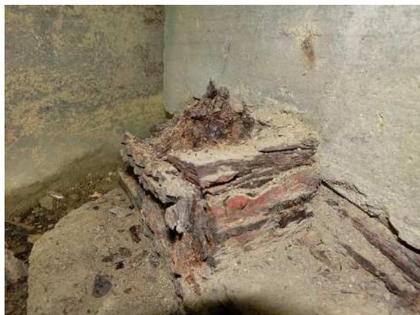
写真 6-16 支承の機能障害（端部の漏水）
