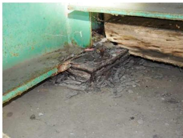
写真 6-2 鋼橋主桁の腐食（端部の漏水）
