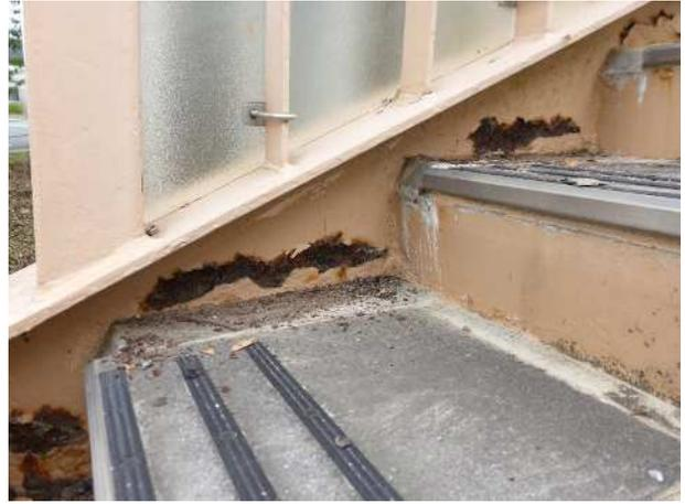
写真 6-50 階段桁の腐食
