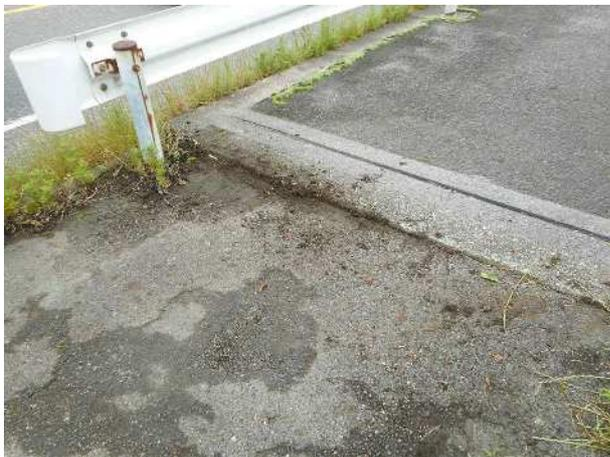
写真 6-21 舗装の凹凸
