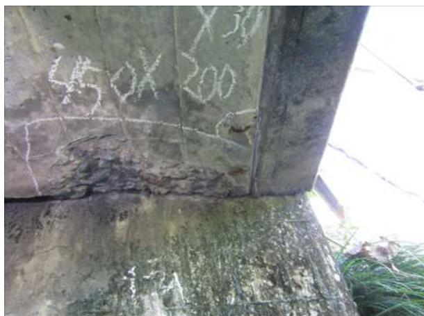
写真 6-11 RC 橋 床版の剥離・鉄筋露出
