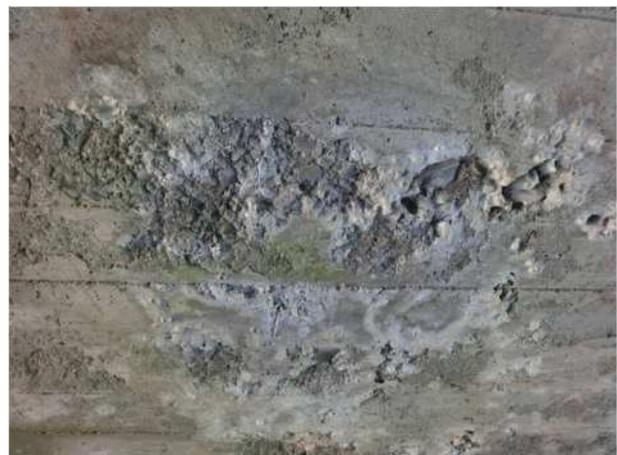
写真 6-10 写真 6-9 の拡大写真（施工不良）
