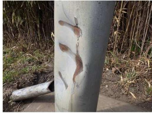
写真 6-52 支柱の変形・欠損
