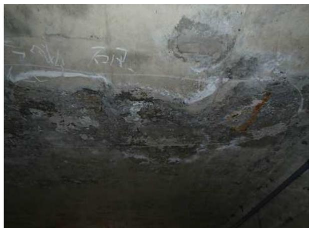
写真 6-12 溝橋 床版の鉄筋露出（施工不良）
