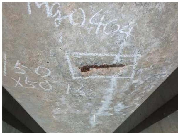
写真 6-6 PC 橋 主桁の剥落（施工不良）
