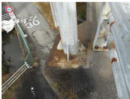
写真 6-56 基礎の腐食
