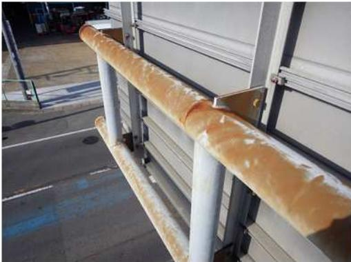
写真 6-53 横梁の腐食
