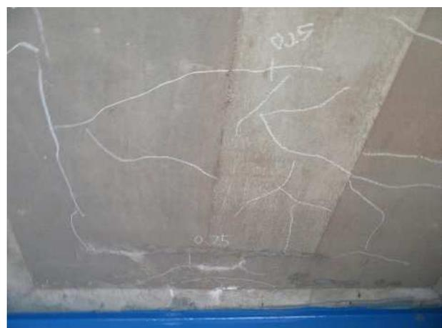
写真 6-4 鋼橋 RC 床版 ひびわれ（疲労）
