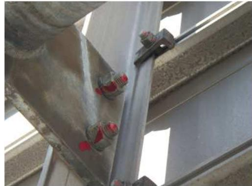
写真 6-54 標識板等の腐食
