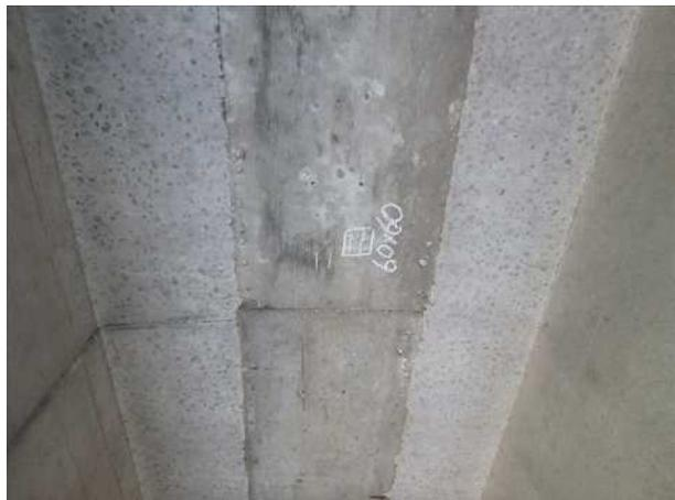
写真 6-7 PC 橋床版のうき（施工不良）
