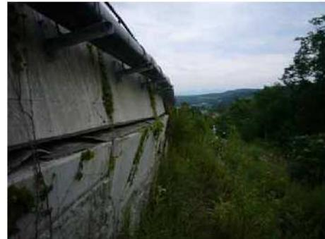
写真 防護柵基礎の傾斜の例
