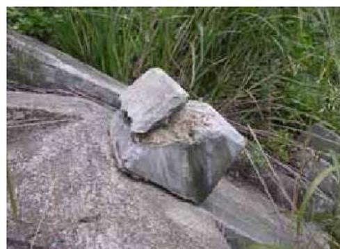
写真 頭部コンクリートの破損の例
