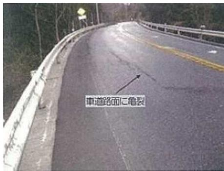
写真 路面の円弧状クラックの例
