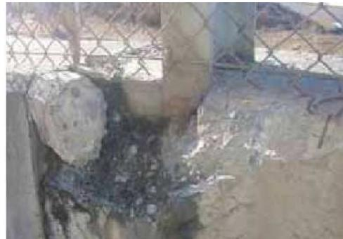
写真 コンクリート部材の剥離・クラックの例（落石防護擁壁）
