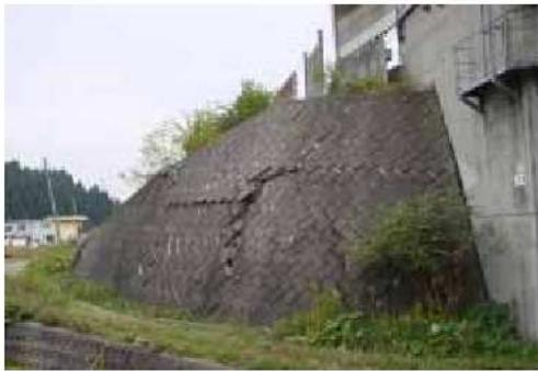
写真 壁面の割れの例
