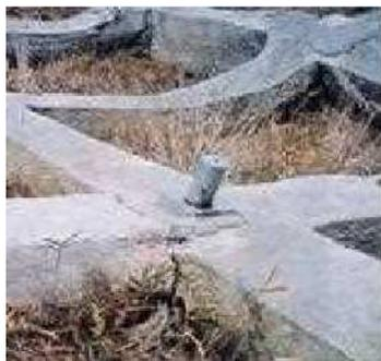
写真 受圧構造物の破損の例
