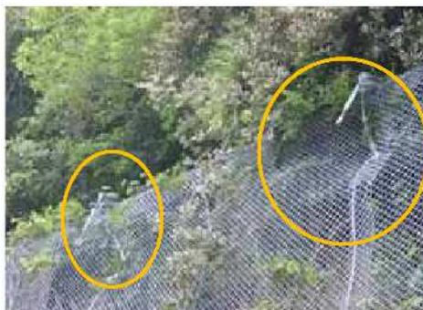
写真 部材の変形・の傾動・鋼部材の破断の例（落石防護網の支柱傾動。金網変形・ワイヤロープ破断）
