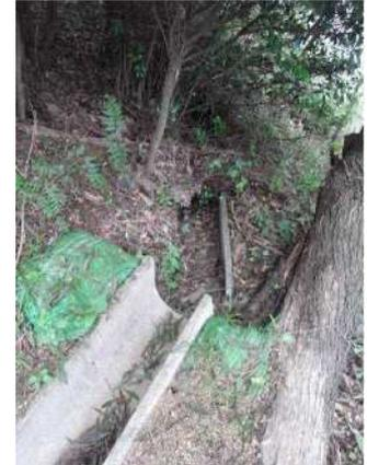
写真 排水溝の破損の例
