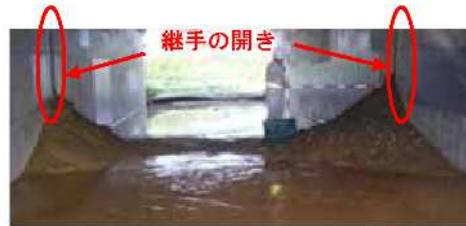
写真 継手の開きおよび
