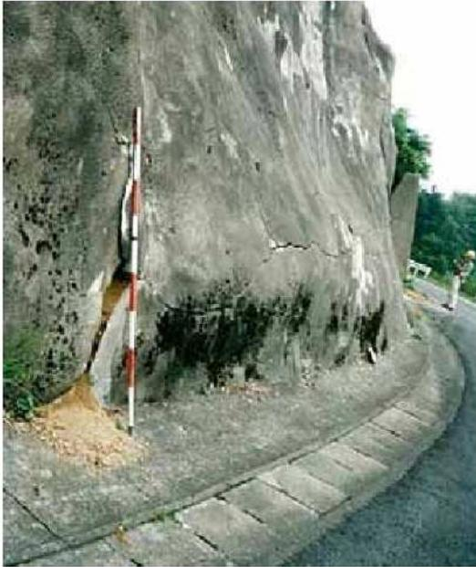
(a) 吹付のり面の水平亀裂およびはらみだし
