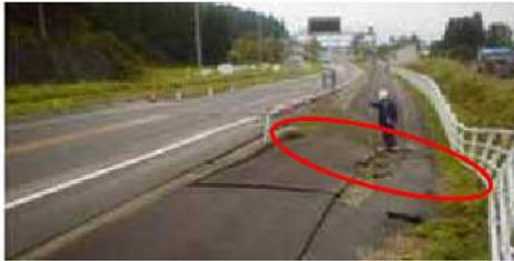
写真 盛土の損傷（沈下）の例
