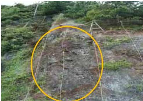
写真 鋼部材の著しい腐食・破断の例（落石防護網の金網）
