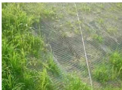
(c) のり尻部が脆弱化し、湧水等により盛土材が流出している例
