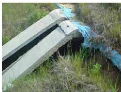
(b) 崩壊性の沈下により排水施設等の下部に空洞が生じている例
