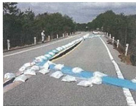
写真 路面の沈下の例
