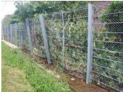
写真 落石防護柵の傾動の例
