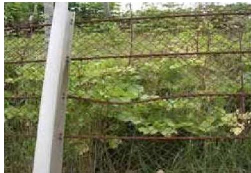
写真 鋼部材の著しい腐食の例（落石防護柵金網・ワイヤーロープ）
