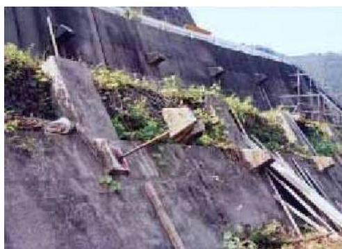
写真 アンカー飛び出しの例
