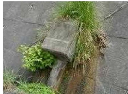
写真 アンカー頭部からの湧水・雑草の繁茂の例
