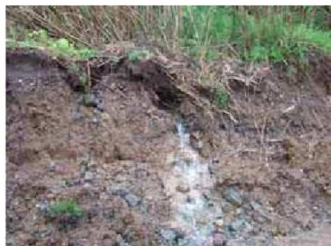
(d) のり尻部の崩壊と湧水の例
