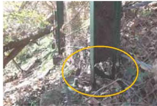
写真 鋼部材の著しい腐食の例（落石防護柵H鋼支柱基部）
