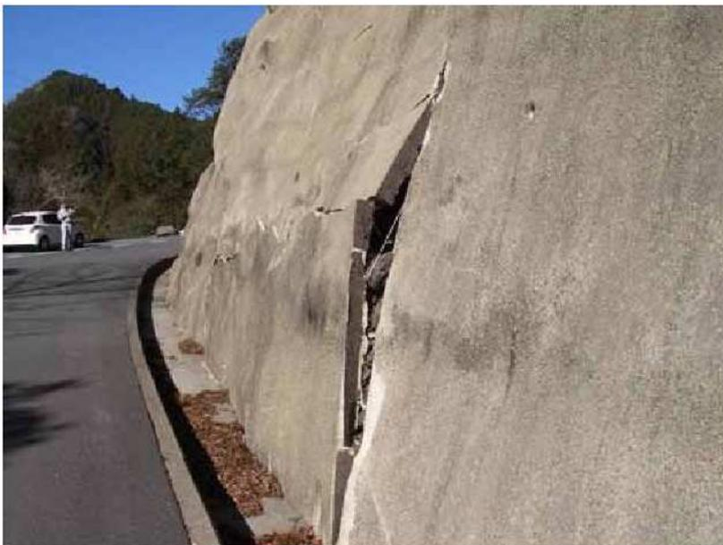
(b) 吹付のり面の目地部分でのずれおよびはらみだし
