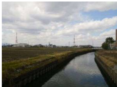
(温常寺幹線排水路)
