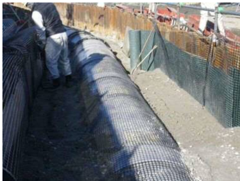
(ジオグリッド施工中)
