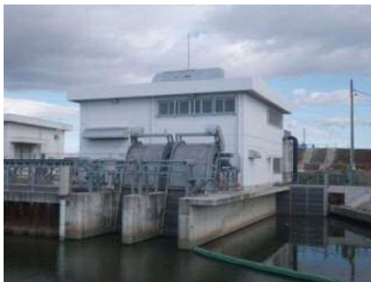
(大神場排水機場)
