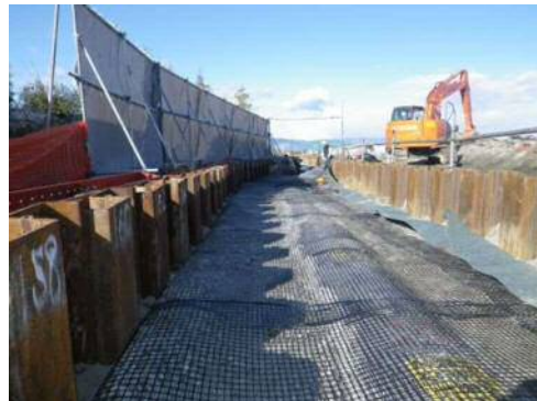
(ジオグリッド設置後)
